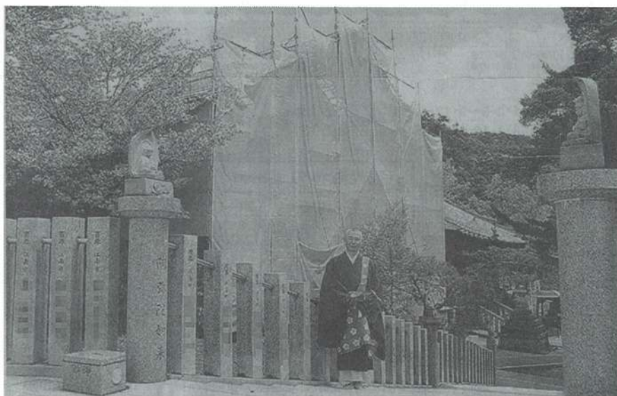
解体修理が行われている随求堂。奥は来年から工事が始まる本堂。中央は松平実胤山主一犬山市継鹿尾の寂光院で
